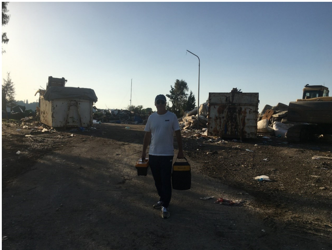
Εικόνα 1.2.12: Απο τις τεχνικές εργασίες στον σταθμο CRF-2 Τεμπλονίου Κέρκυρας στις 22/10.
