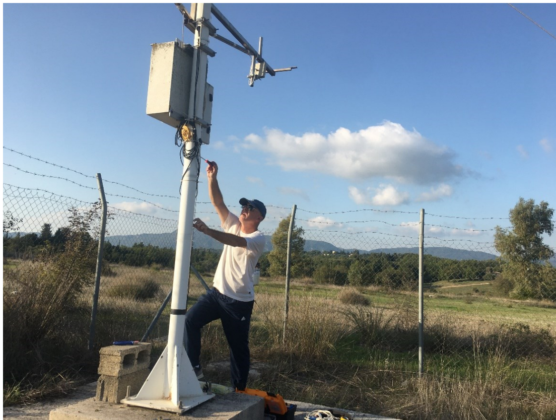
Εικόνα 1.2.10: Απο τις τεχνικές εργασίες στον σταθμο CRF-2 Τεμπλονίου Κέρκυρας στις 22/10.
