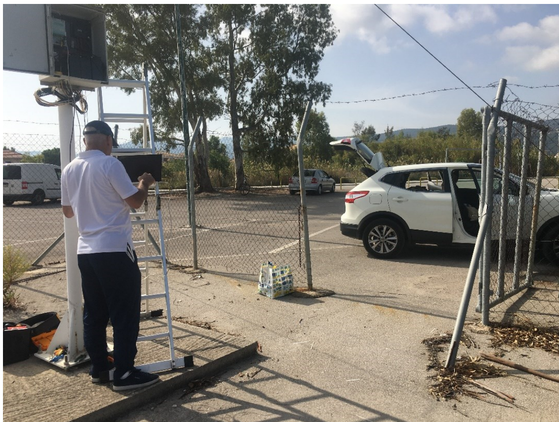
Εικόνα 1.2.16: Απο τις τεχνικές εργασίες στον σταθμο LFK-1 Λευκάδας στις 23/10.
