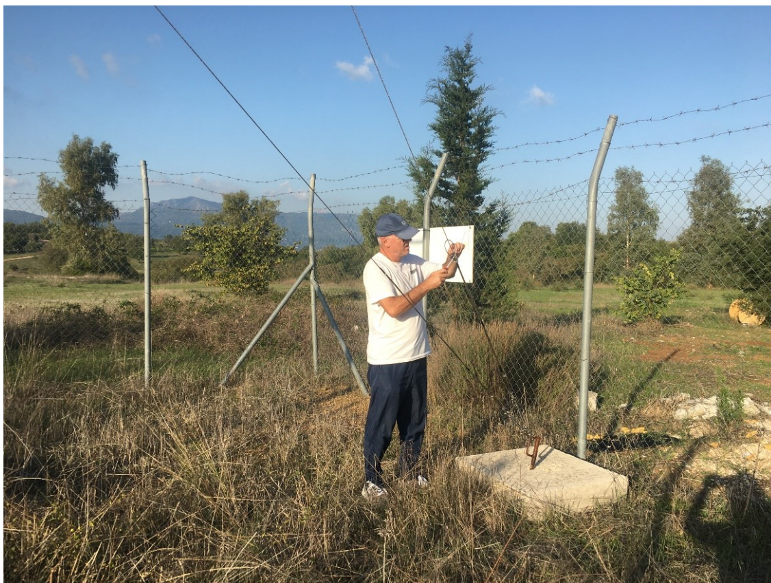
Εικόνα 1.2.11: Απο τις τεχνικές εργασίες στον σταθμο CRF-2 Τεμπλονίου Κέρκυρας στις 22/10.
