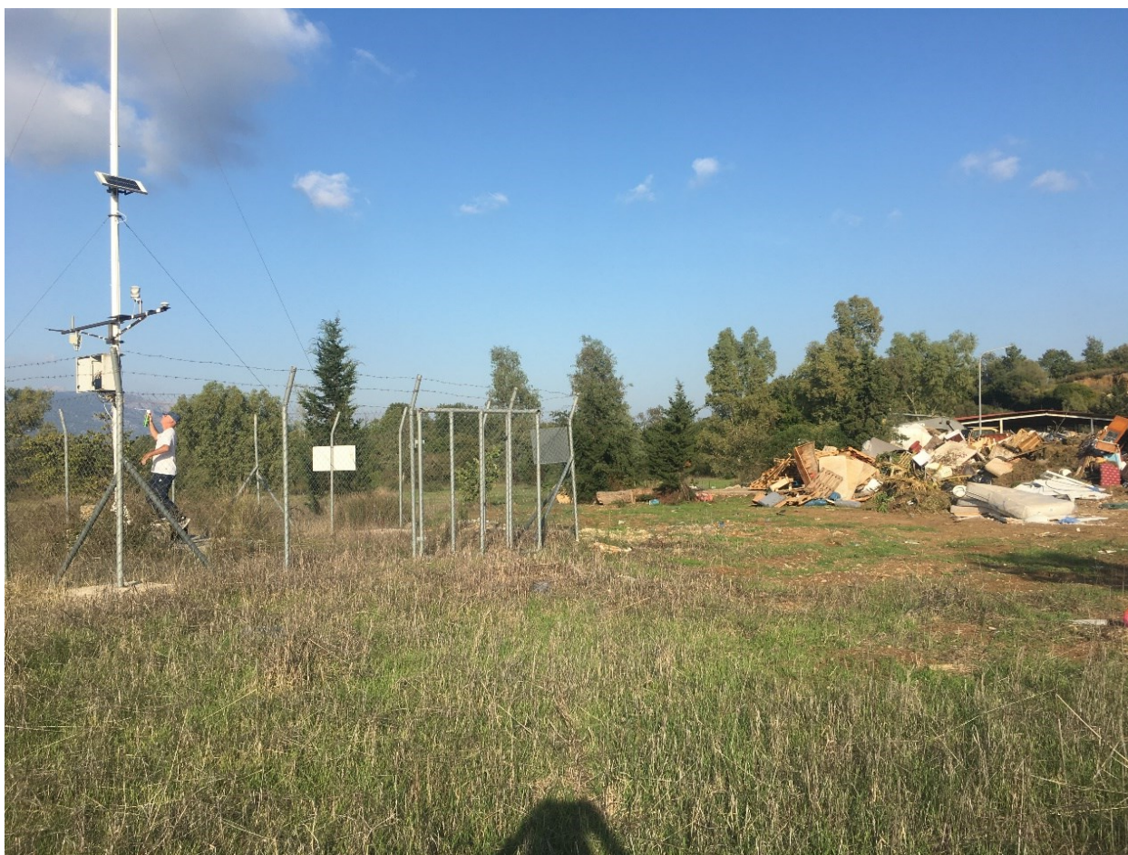
Εικόνα 1.2.9: Απο τις τεχνικές εργασίες στον σταθμο CRF-2 Τεμπλονίου Κέρκυρας στις 22/10.
