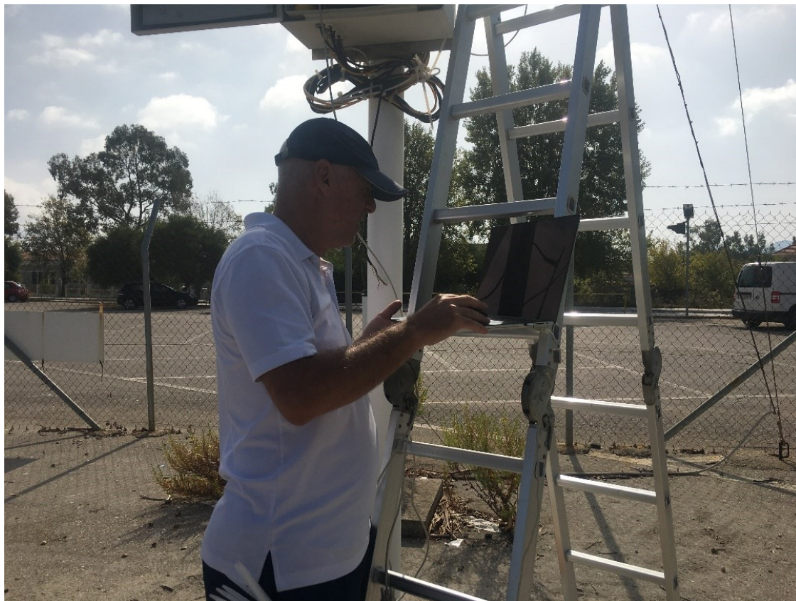
Εικόνα 1.2.15: Απο τις τεχνικές εργασίες στον σταθμο LFK-1 Λευκάδας στις 23/10.
