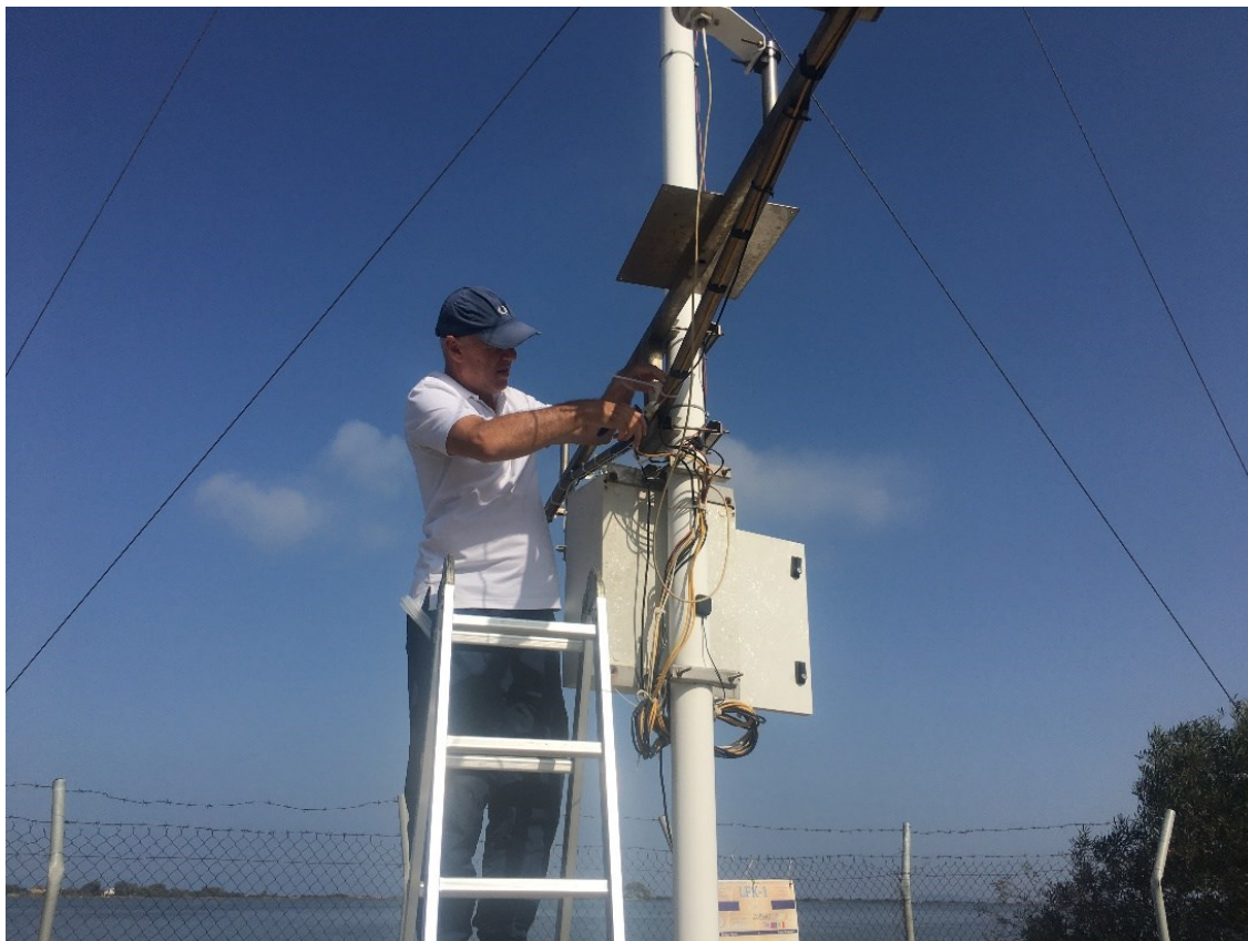
Εικόνα 1.2.17: Απο τις τεχνικές εργασίες στον σταθμο LFK-1 Λευκάδας στις 23/10.
