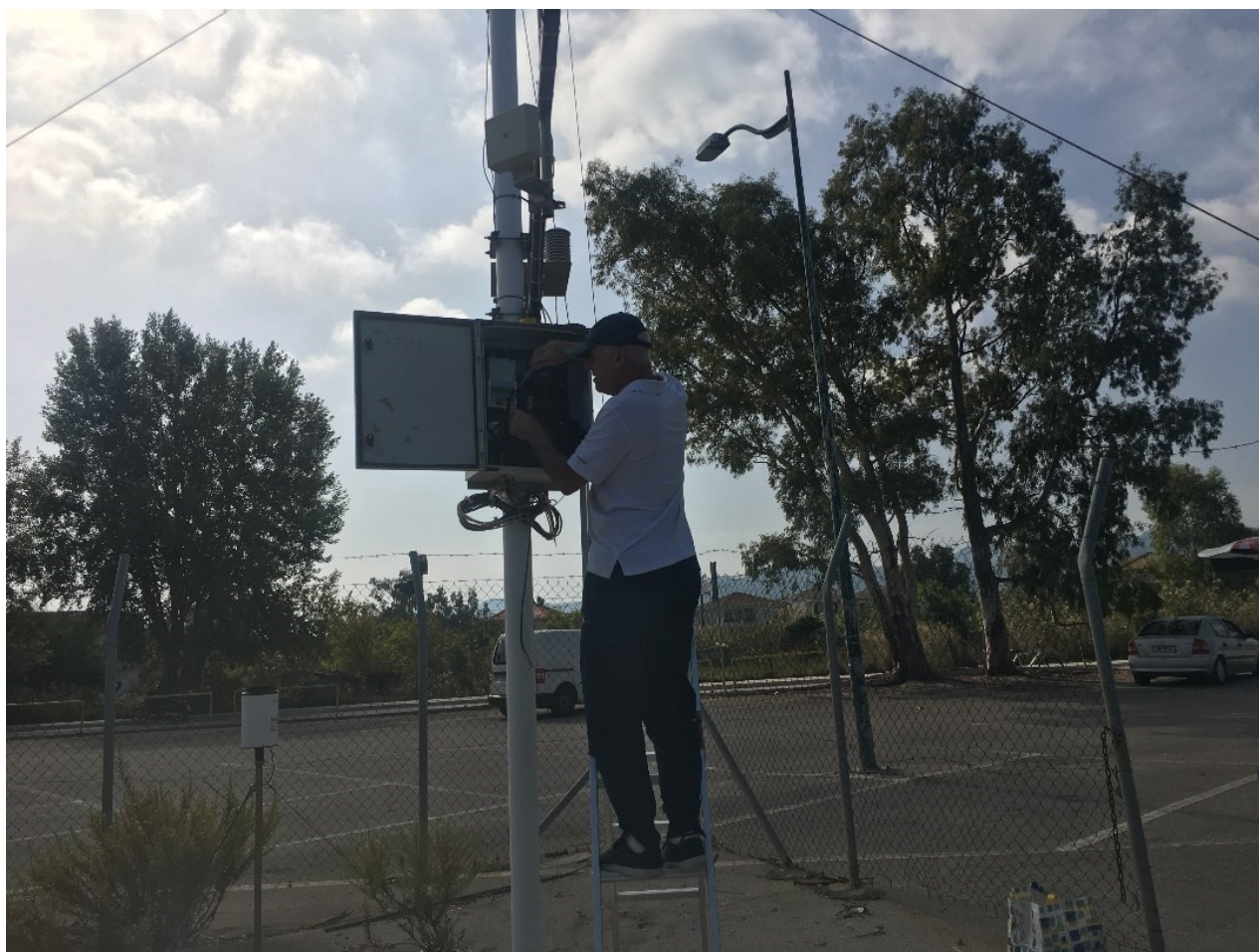
Εικόνα 1.2.14: Απο τις τεχνικές εργασίες στον σταθμο LFK-1 Λευκάδας στις 23/10.
