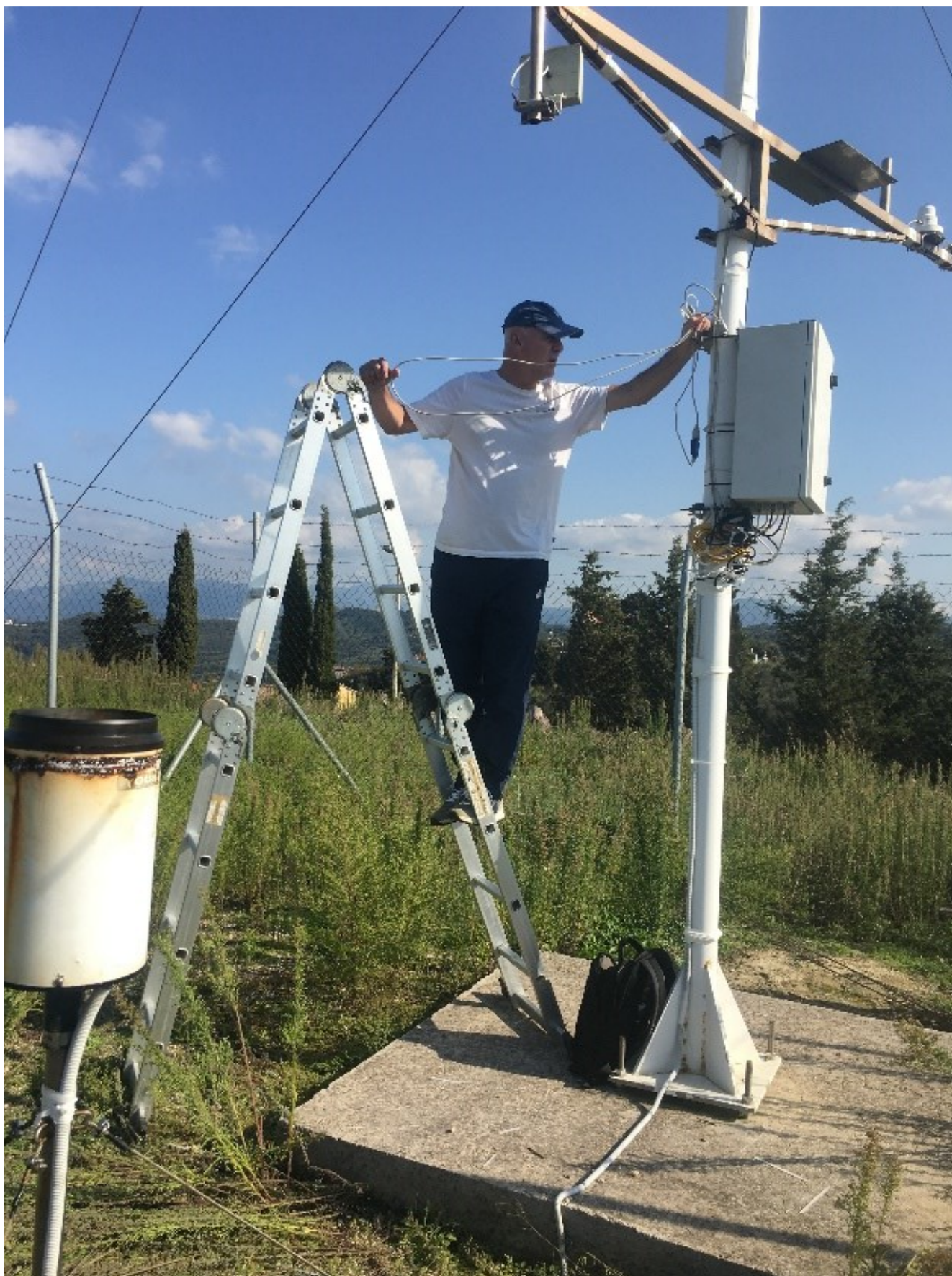
Εικόνα 1.2.8: Απο τις τεχνικές εργασίες στον σταθμο CRF-1 Αυλιωτών ΒΔ Κέρκυρας στις 22/10.
