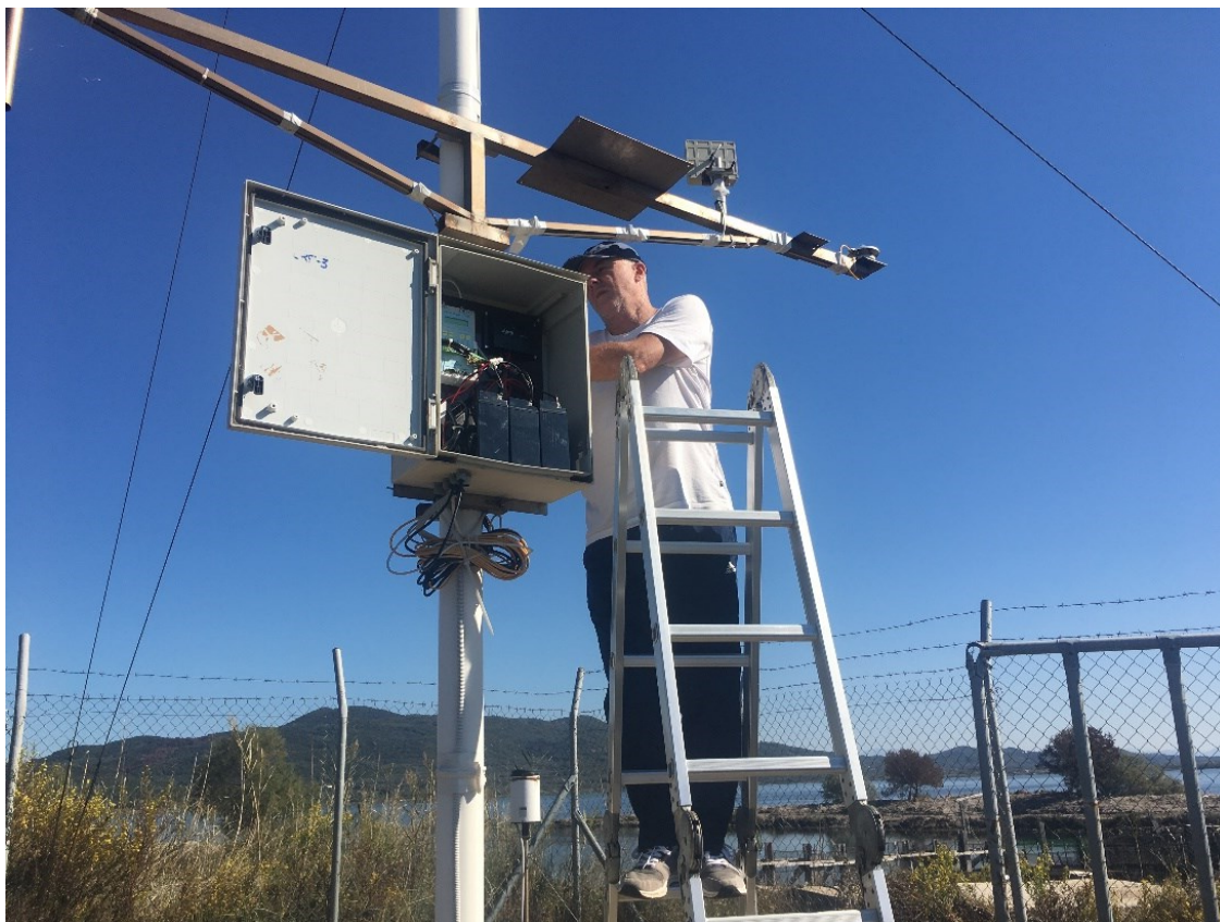
Εικόνα 1.2.2: Απο τις τεχνικές εργασίες στον σταθμο CRF-3 Λίμνης Κορισσίων στις 20/10.
