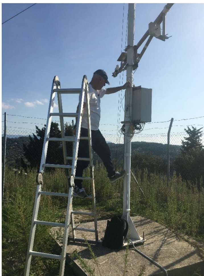
Εικόνα 1.2.7: Απο τις τεχνικές εργασίες στον σταθμο CRF-1 Αυλιωτών ΒΔ Κέρκυρας στις 22/10.
